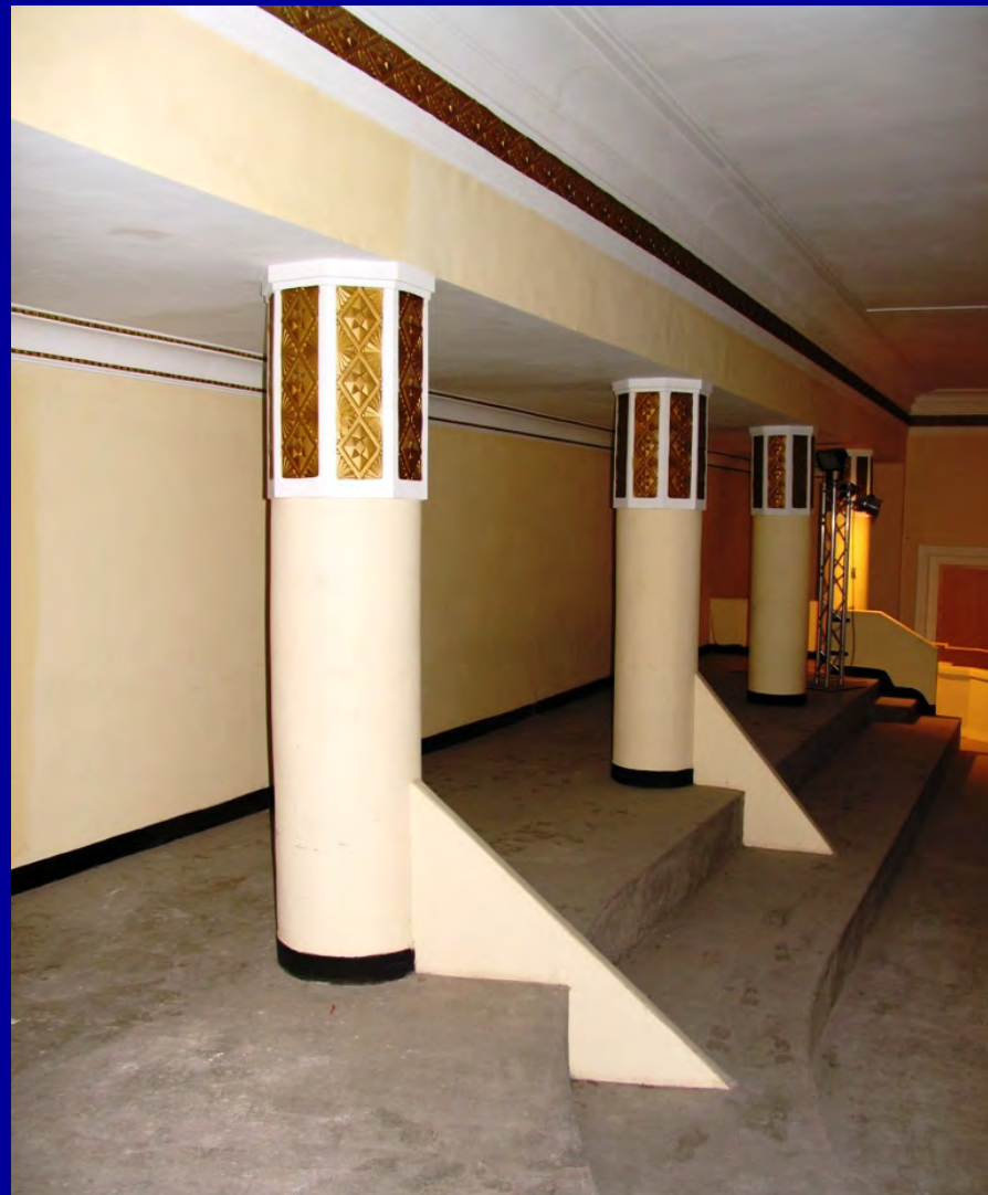
F. Di Fausto - A. Manassi, « Casa degli Italiani », Casablanca, il teatro durante i lavori di restauro, 1930-31
